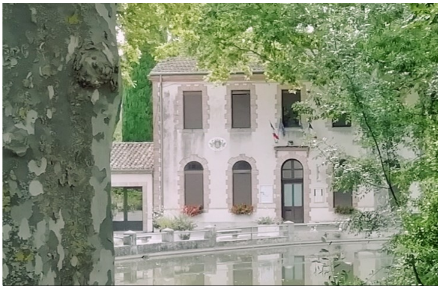
Mairie de Roumens avec sa façade à nettoyer. © D. Lasance
